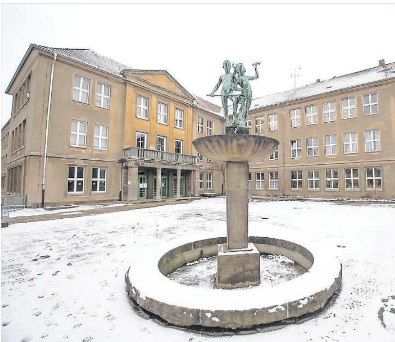
Bis 2007 war auf der Bernhardstraße das Fritz-Loeffler-Gymnasium untergebracht. Seitdem wird die Schule immer wieder als Ausweichstandort genutzt. Für die Dölzschener Grundschüler mussten unter anderem die Sanitäranlagen umgebaut werden. Foto: Sven Elger
