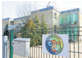
Die marode Kita in der Roquettestraße 16 wird 2014 abgerissen. Eine Sanierung des Plattenbaus lohnt sich nicht. Die Kinder ziehen dann in einen Neubau an der Gottfried-Keller-Straße.
