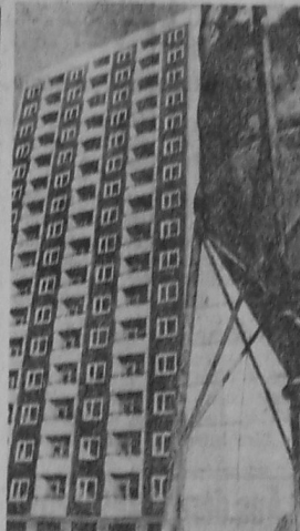
NOCH FINDET man überall Spuren des Baugeschehens, auch wenn die ersten Mieter schon eingezogen sind.
