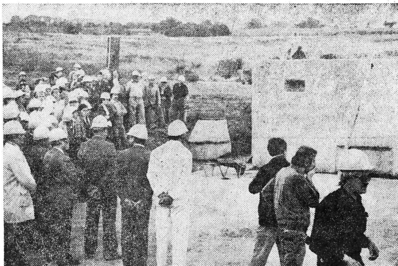
Grundsteinlegung für das Neubaugebiet Dresden-Gorbitz war am 21. August 81. Foto: ST/Archiv
